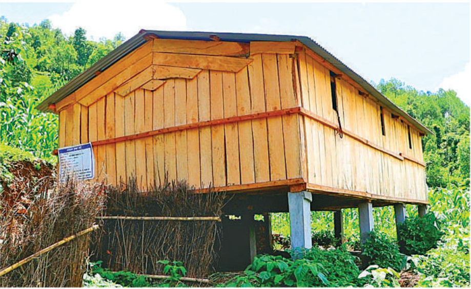
सिद्धिचरण नगरपालिका २ मुखिया टोलमा निर्माण गरिएको आधुनिक बाख्रा खोर ।
